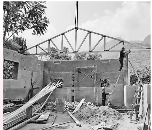
工作人员拆除违建。(闽侯治违办供图)
