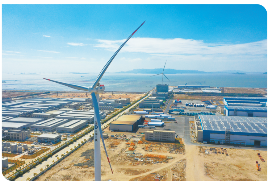
福建三峡海上风电国际产业园。
