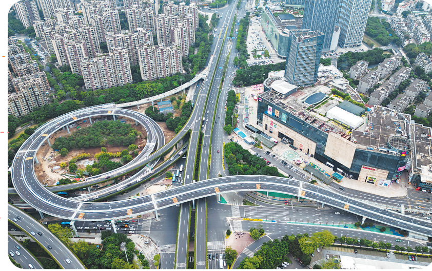
尤溪洲立交改造项目。
