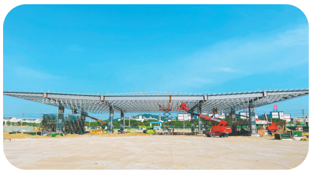
▲福州长乐国际机场综合保税区片区开发项目1#和2#海关卡口钢结构主体吊装完成。
