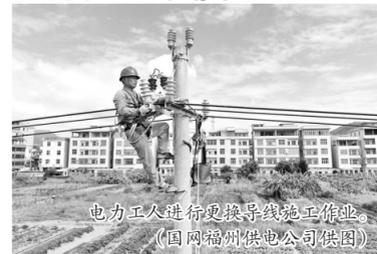
电力工人进行更换导线施工作业。(国网福州供电公司供图)
