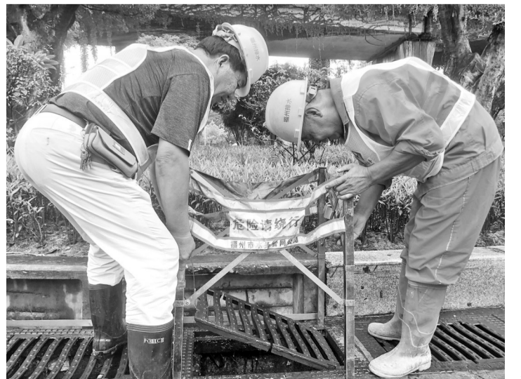
双湖高架桥下，工作人员预先打开边井。(受访部门供图)
