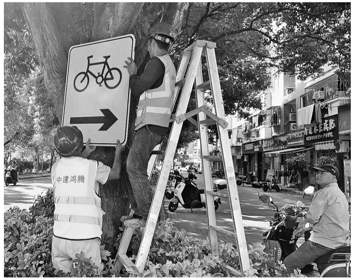
施工人员在金河路安装交通标识牌,做好施工前的各项准备。(市排水公司供图)
