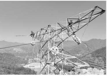
电力工人在进行放线施工。(国网福州供电公司供图)
