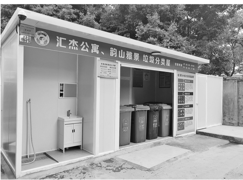
改造提升后的汇杰公寓垃圾分类屋。(市城管委供图)
