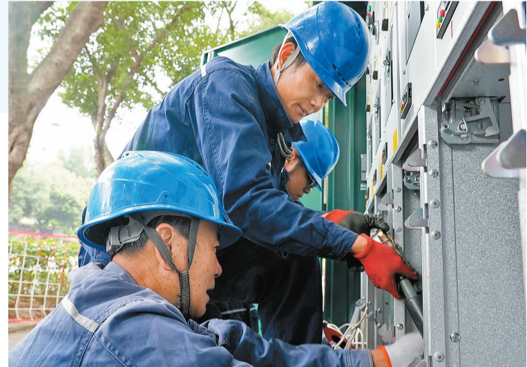
电力工人在嘉和苑小区配电房内安装供电应急接口。陈德钧摄
