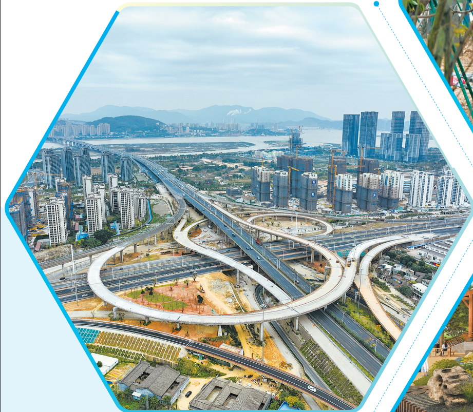
▲三江口大桥南连接线各匝道陆续建成。本报记者 池远摄
