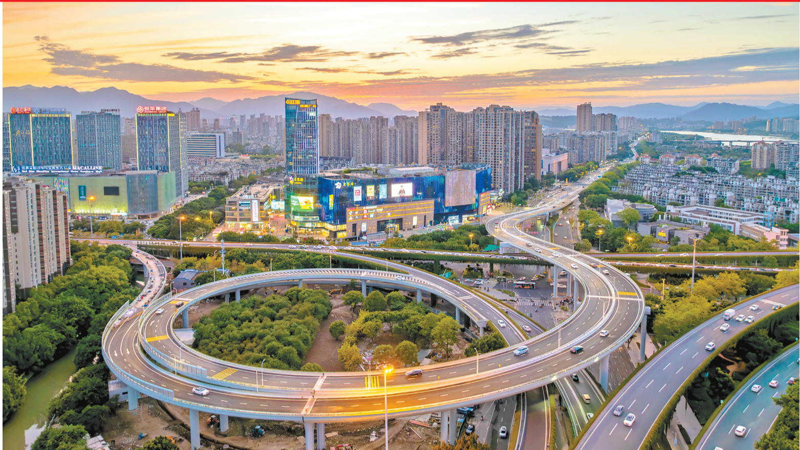
尤溪洲大桥南立交改造完成。本报记者 陈暖摄
