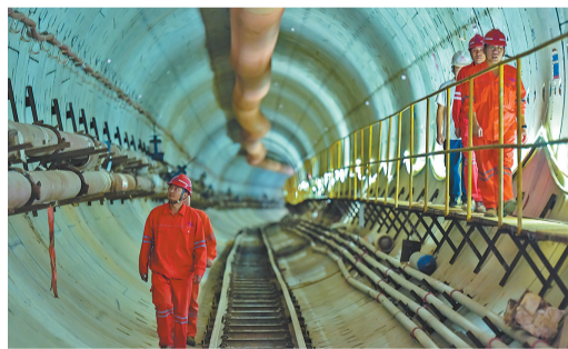
福州地铁4号线后通段洪塘站至金牛山站区间右线盾构顺利完成接收。
