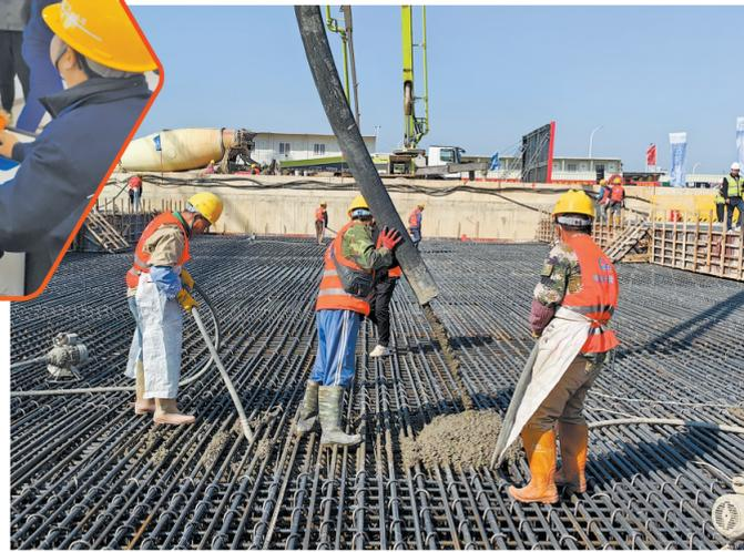
机场综合枢纽地下市政配套工程国铁车站最后一块顶板浇筑。(交建供图)
