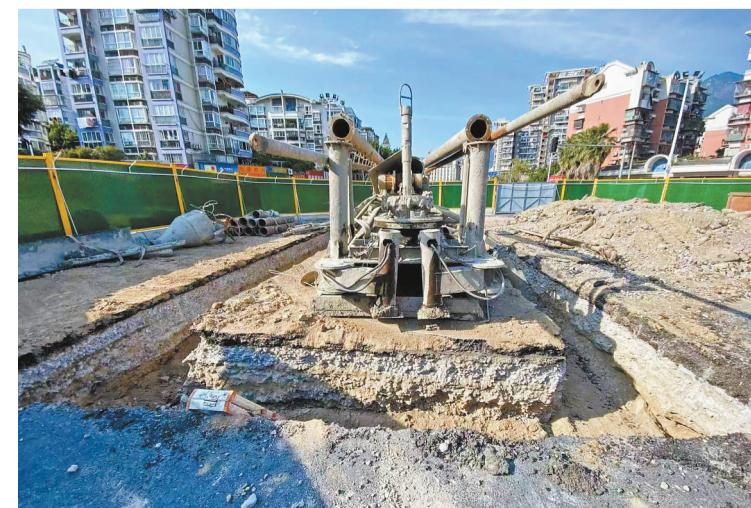
工作井基坑支护灌注桩施工沟槽开挖。(市排水公司供图)
