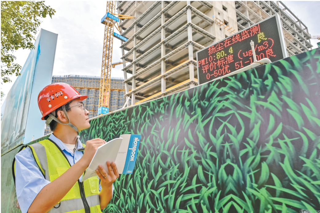
在厦航广场项目现场,一块LED显示屏实时显示扬尘和噪声的各种数值。
