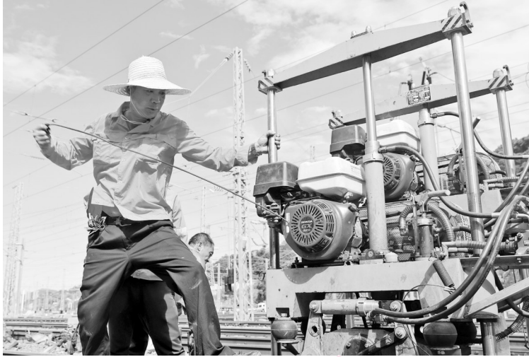
南铁福州工务段工作人员发动小型液压捣固机。 易威摄
