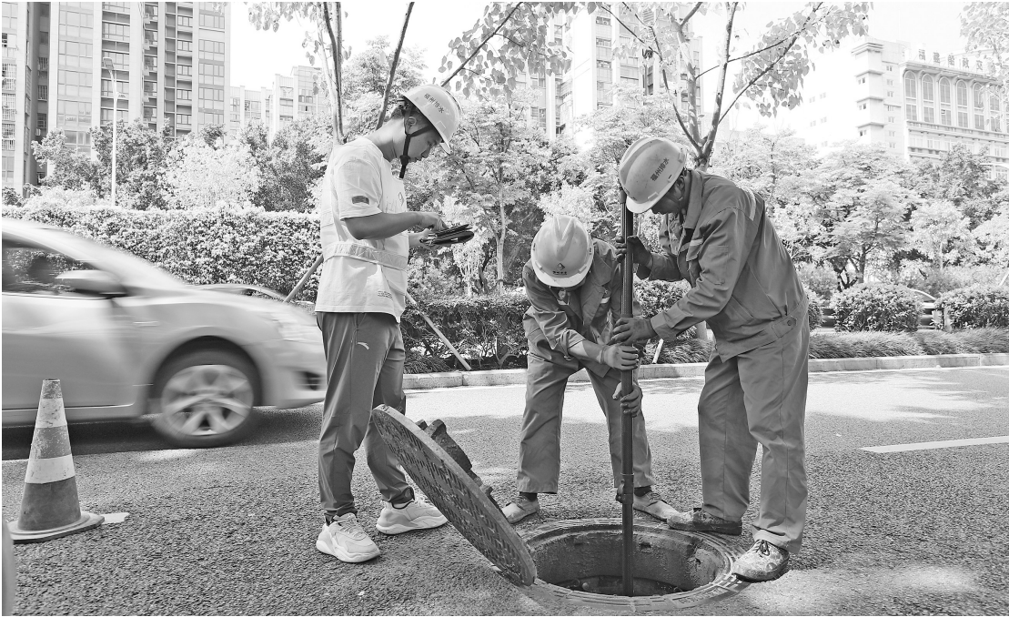
施工人员在排查雨污分流情况。(市排水公司供图)
