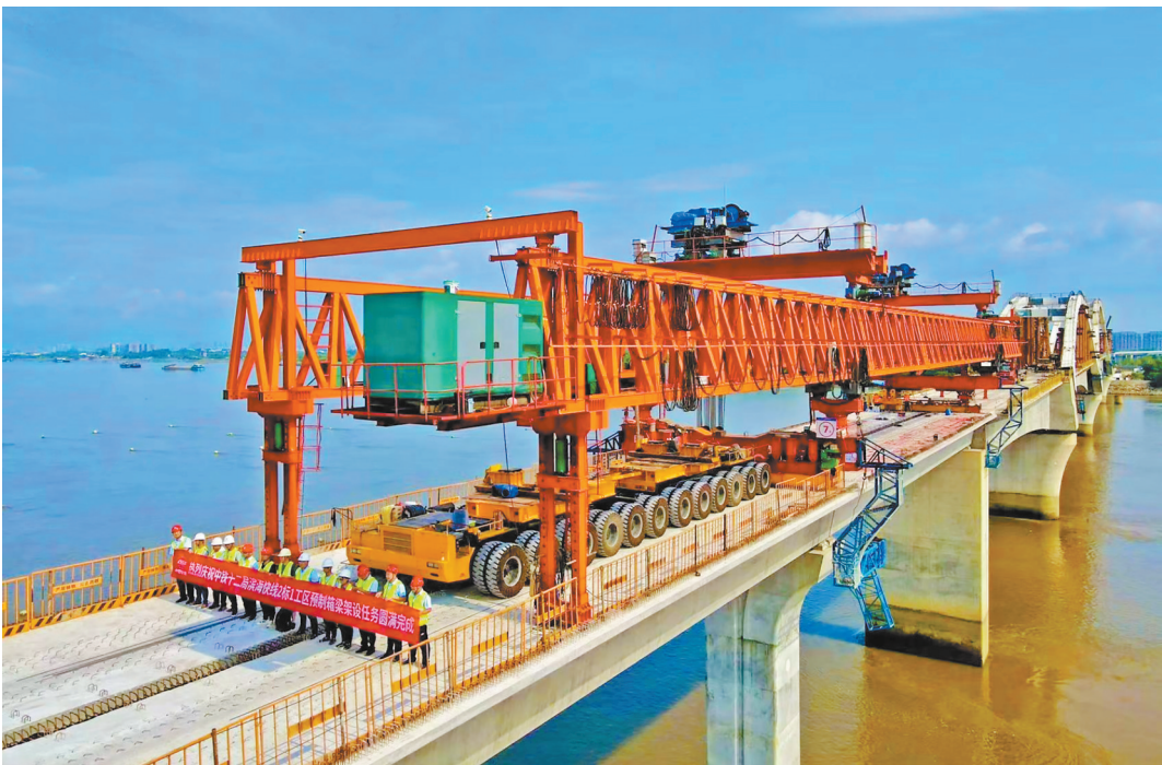
帝封江站至祥谦站的高架段采用40米预制大箱梁施工模式。(福州地铁供图)
