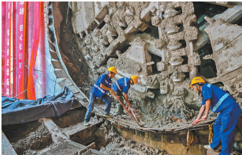
福州火车站站至东门站区间右线盾构机刀盘破土而出,标志着滨海快线全线“洞通”。
