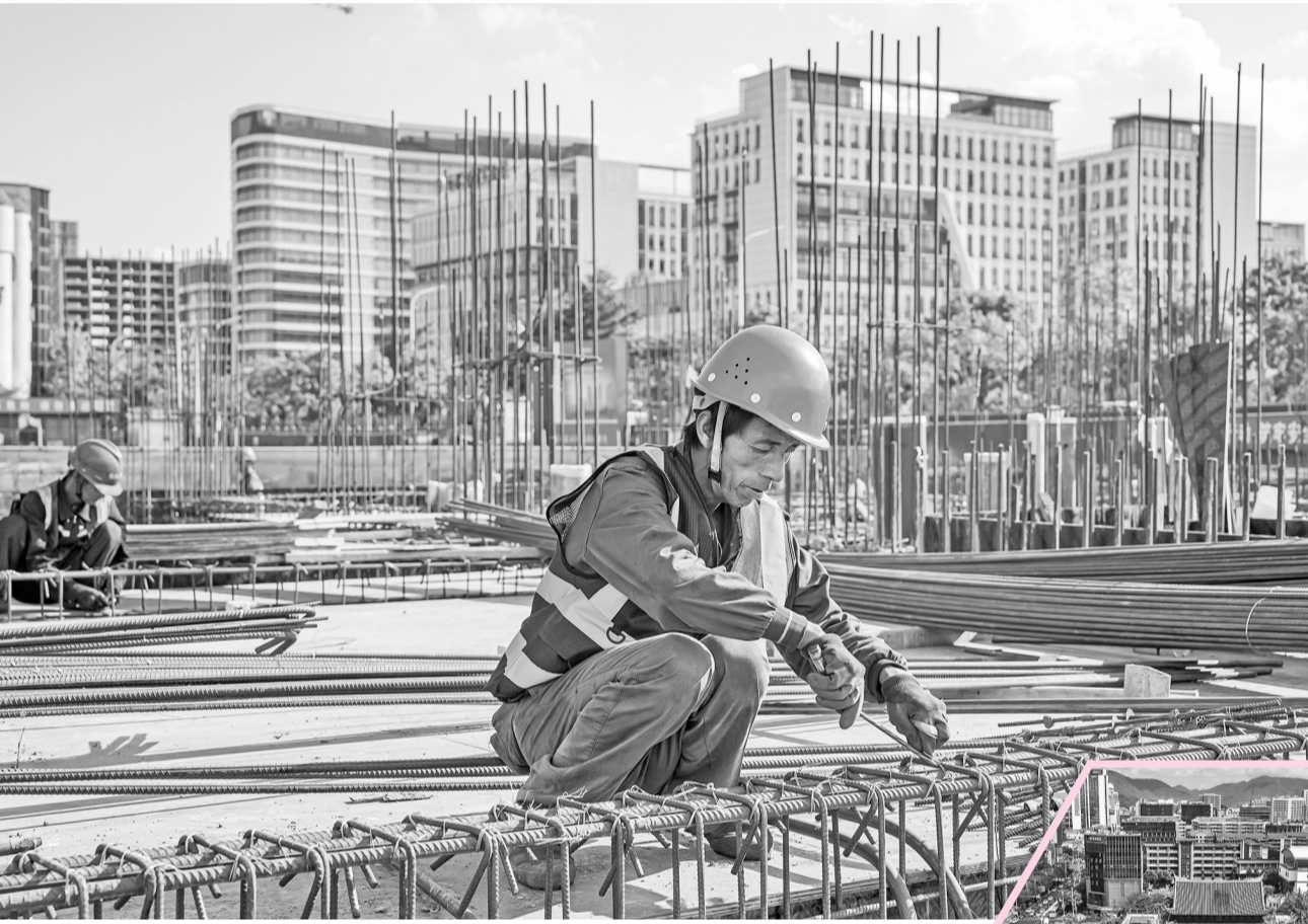
工人在福州高新区新洲安置房一期项目工地绑扎钢筋。本报记者 原浩摄
