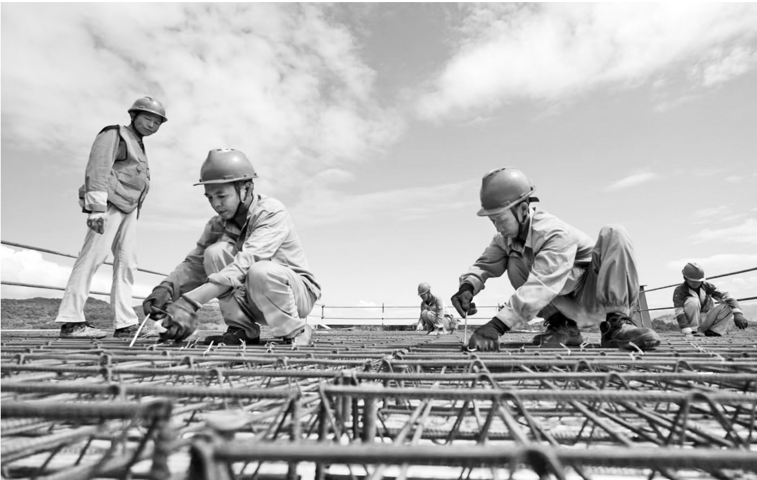
工人在官坂220千伏变电站建设现场绑扎钢筋。(国网福州供电公司供图)
