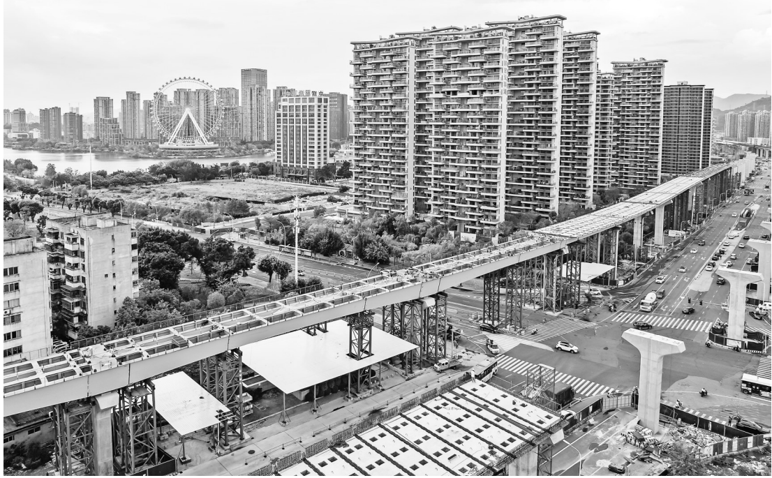
◀前横路快速化改造工程跨福新路路口段左幅钢箱梁合龙。 本报记者 陈暖暖
