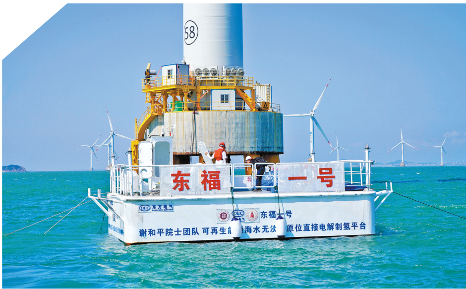
海水直接电解制氢技术海试在“东福一号”上开展。(中国东方电气集团有限公司供图)
