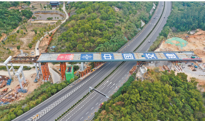
福州机场第二高速公路项目跨高速半幅钢箱梁顶推完工。陈花供图
