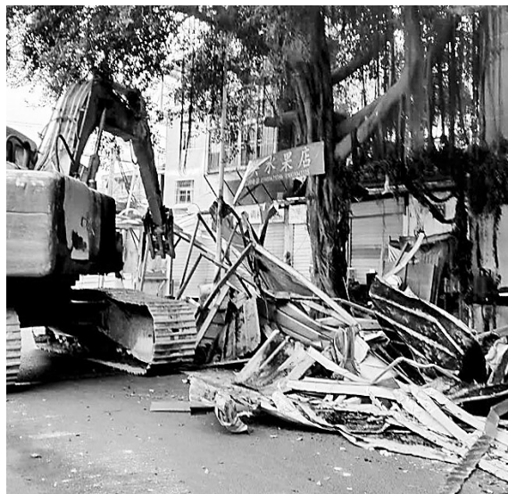
仓山区建新镇沿街违建被拆除。
