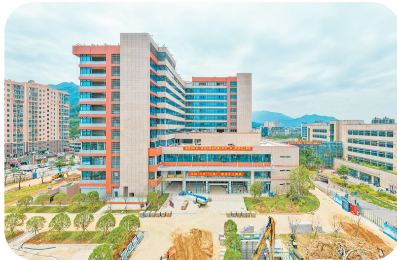
正在建设中的福建医科大学附属协和医院（旗山院区）二期工程。
