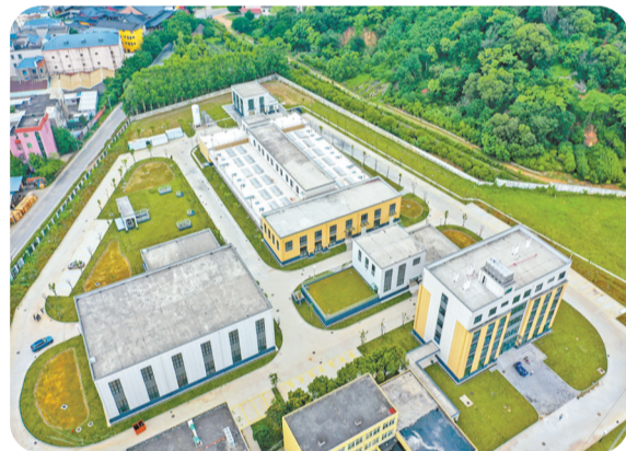
长乐东区水厂水质提升工程。通讯员 姜亮摄
