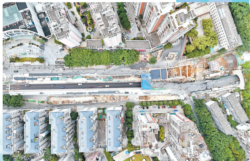
象山隧道拓宽改造工程。(项目方供图)
