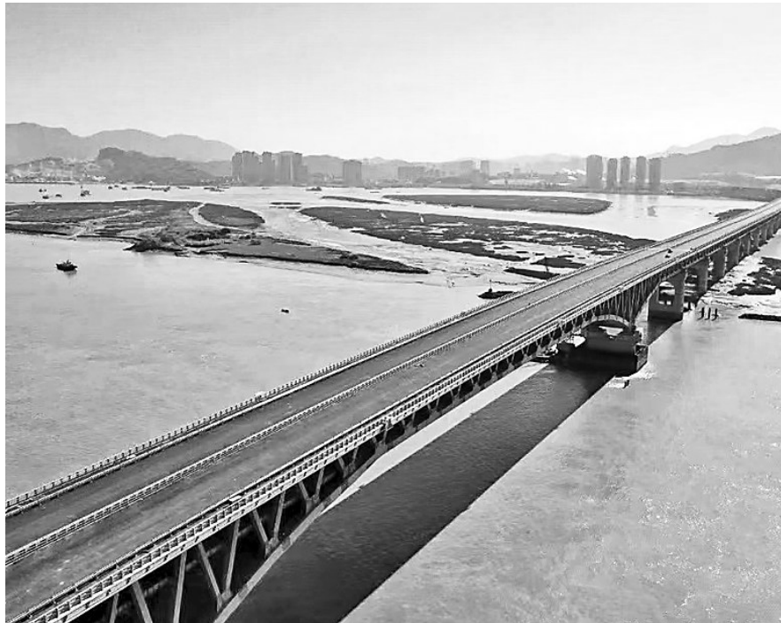
道庆洲大桥航拍图。
