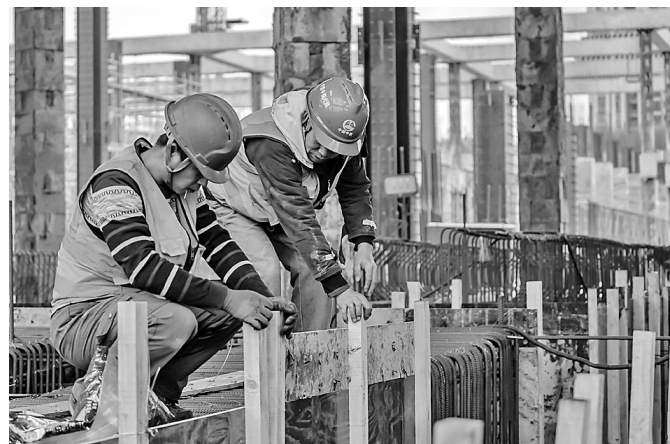
工人在滨海快线东升停车场工区施工。
