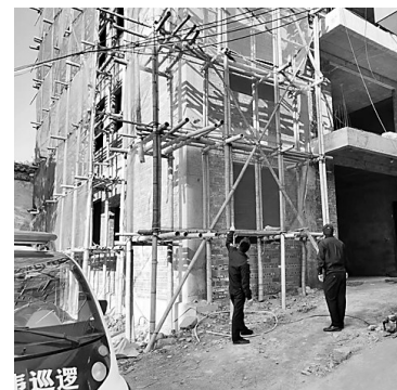
连江透堡开展自建房检查。
