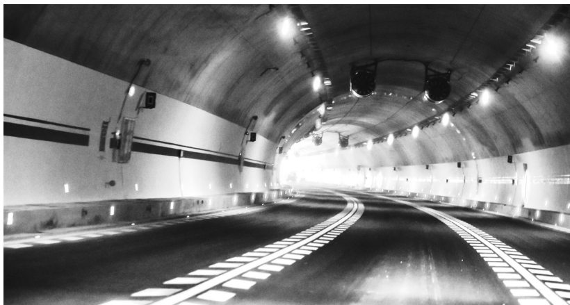
北岭隧道的灯光环境方便车辆快速平稳通行。
