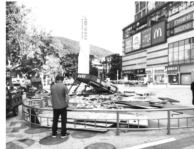
违建“售卖屋”被拆除。
