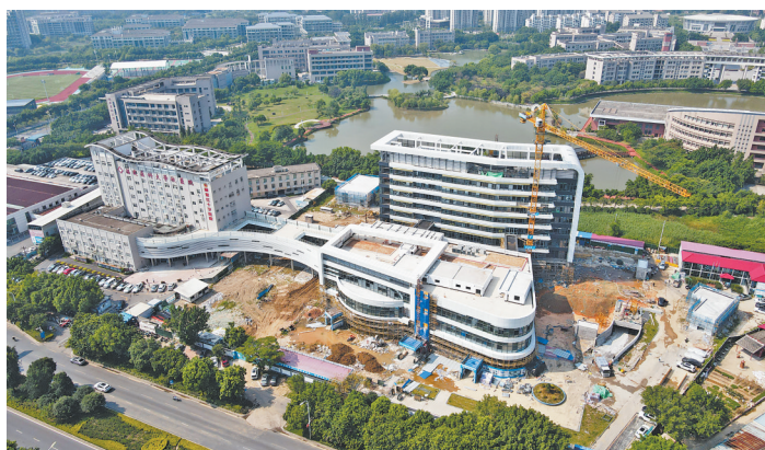
闽侯上街中心卫生院扩建项目正在施工。
