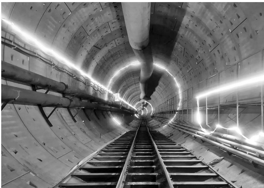
滨海新城站—滨机中间风井右线隧道洞通。
