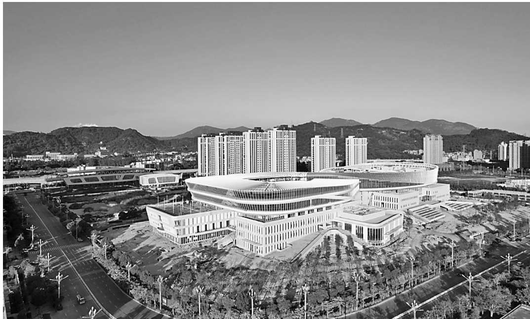
目前,长乐区图书馆新馆已经进入内部装修阶段。
