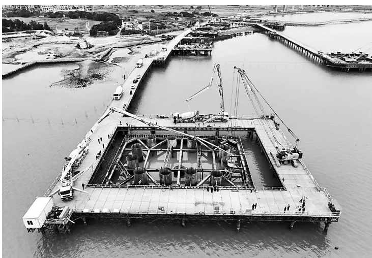
东港特大桥主墩承台垫层施工正式启动。福清市影像中心供图
