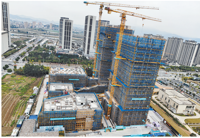
新投时代中心已实现主体结构封顶。
