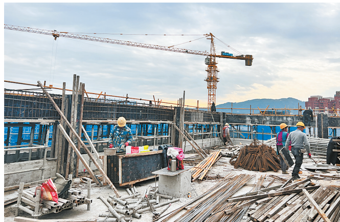
项目地块一建筑主体结构封顶。
