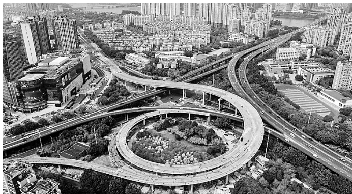
尤溪洲大桥南立交改造主线桥主体结构即将完工。
