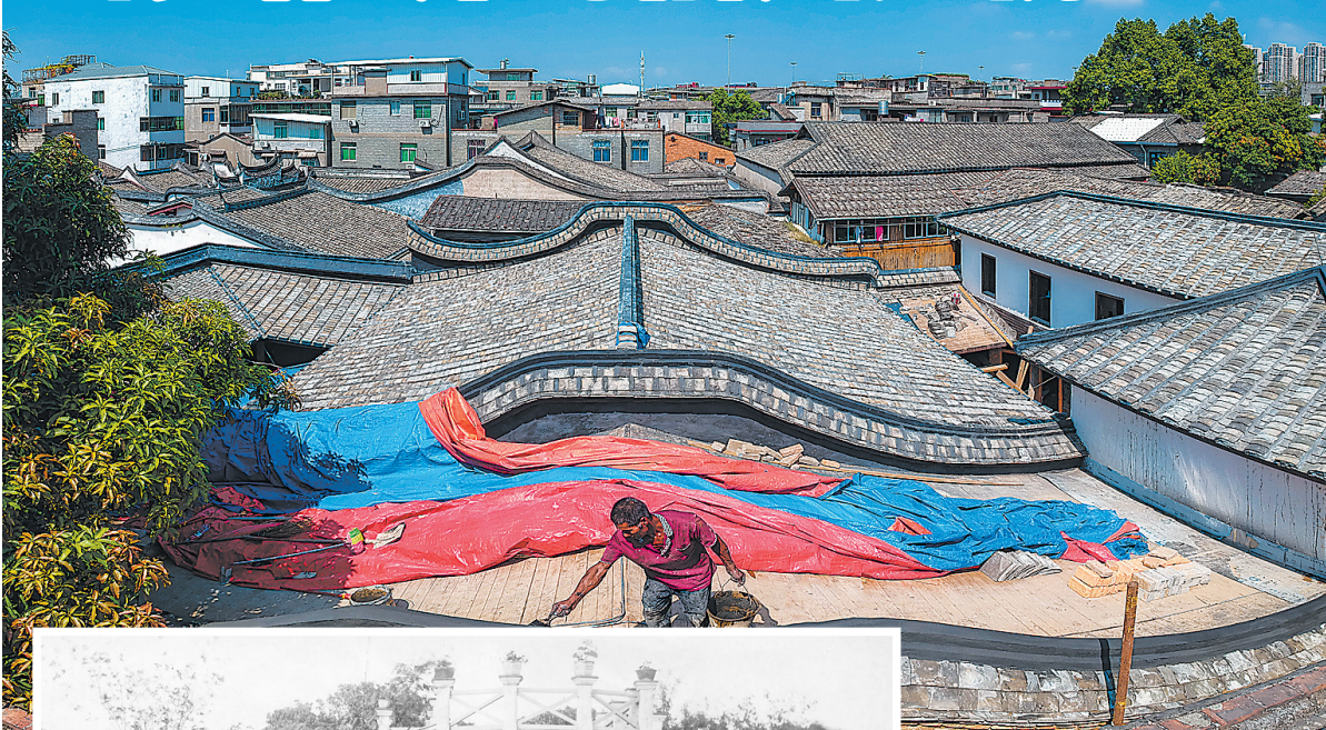
古建修复人员在钟园屋顶作业。
