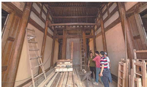
修复中的钟园正厅。
